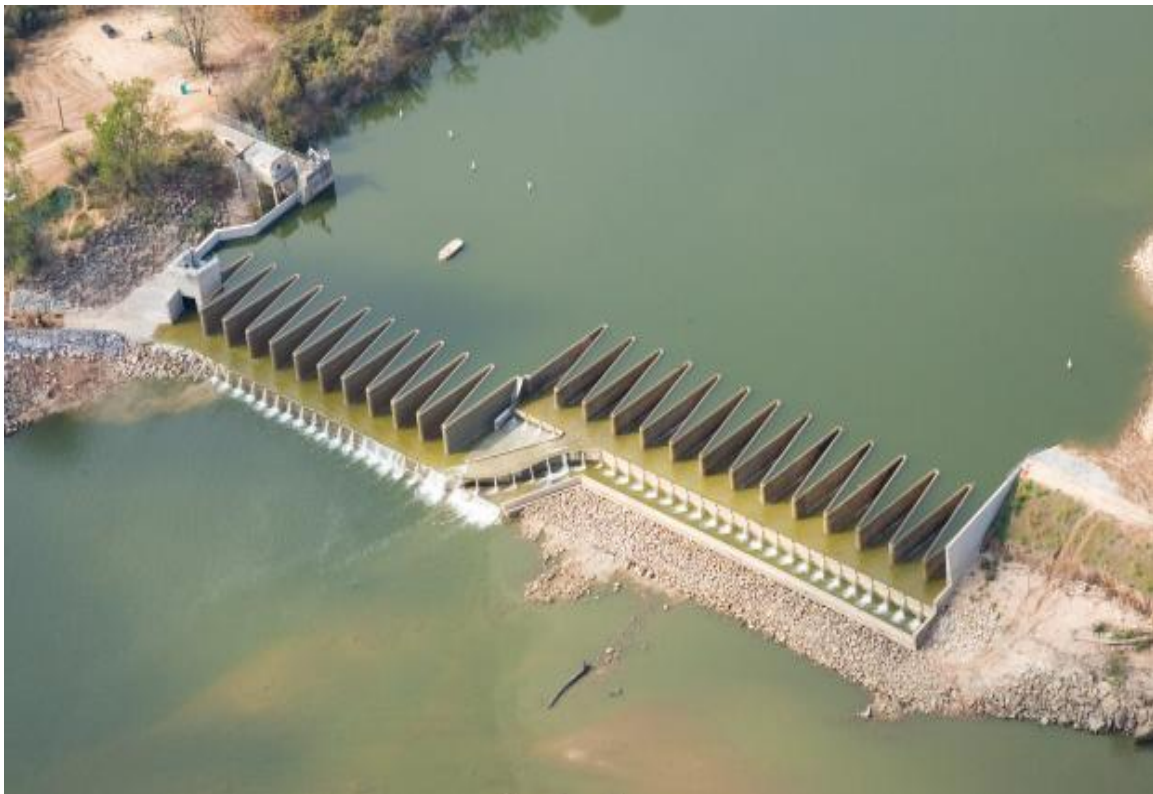
Fig 3.1 Brazos dam, Texas, USA
