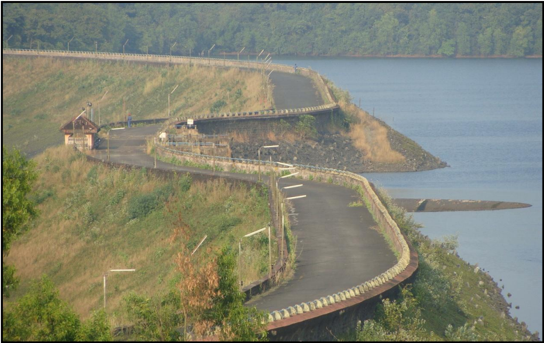
View of s Salaulim Dam,Goa
