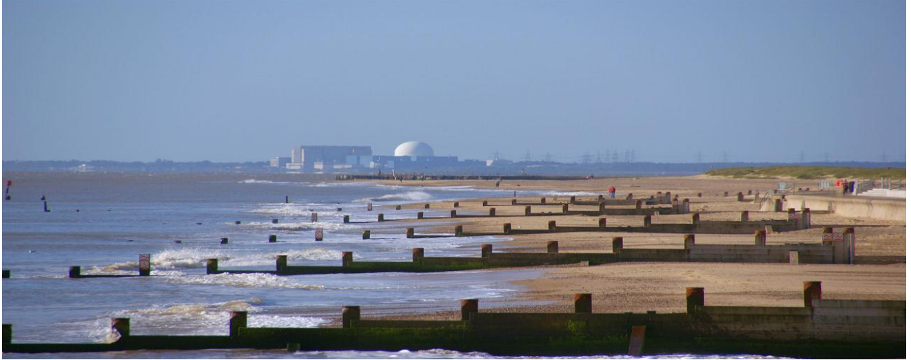
Fig: 1.5: Permeable Groynes
